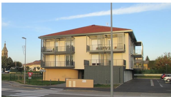
Logements collectifs à Jardin (38)
