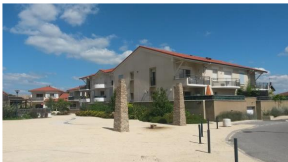
Logements collectifs à Champagne (26)
